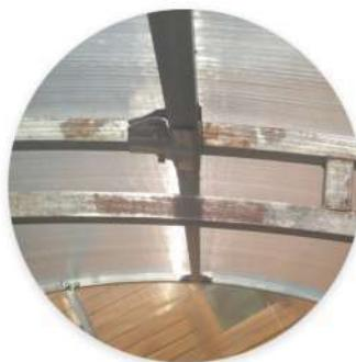
Коррозия оцинкованной трубы
